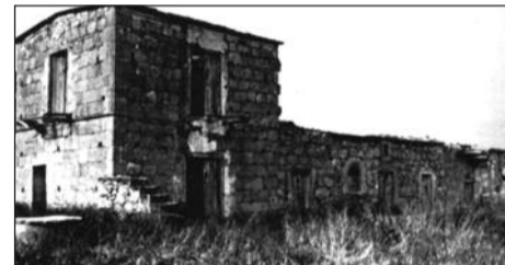
Πετρόκτιστο διώροφο στη Βοκολίδα με τα σημάδια της ερήμωσης
